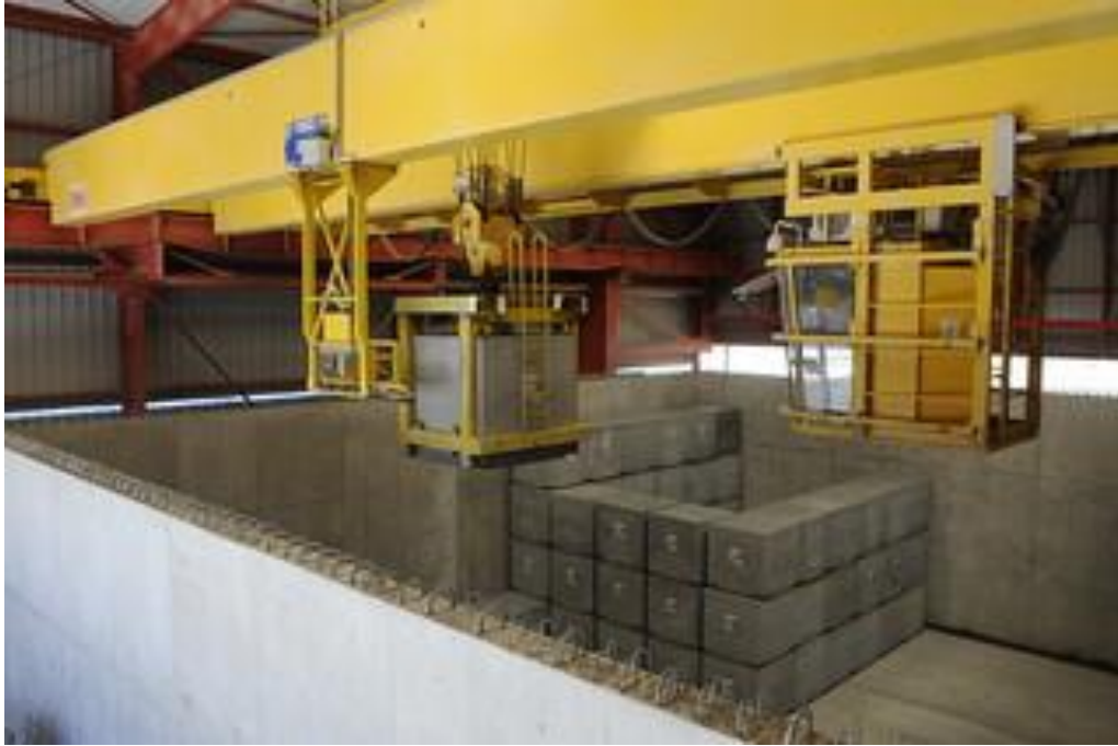
Riempimento di una delle celle con i rifiuti stabilizzati contenuti nei manufatti di cemento
