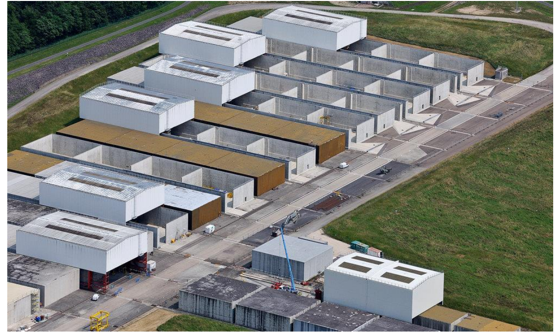
Celle di cemento armato e coperture mobili per il progressivo riempimento
