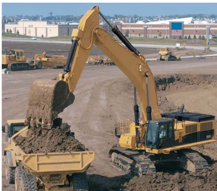
Figura 18. Escavatore idraulico e dumper in caricamento
