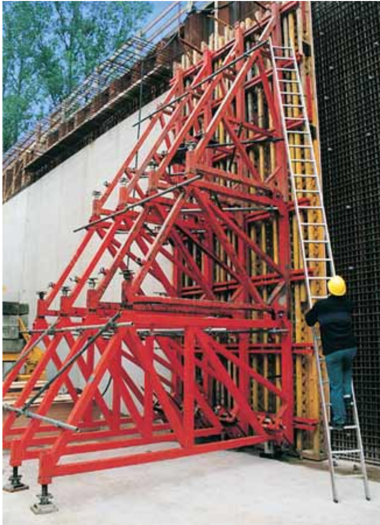
Figura 19. Cassero tipo per pareti verticali con sistema di sostegno e controspinta
